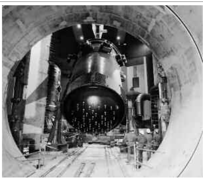
Installation d'un réacteur de chaudière sur site
