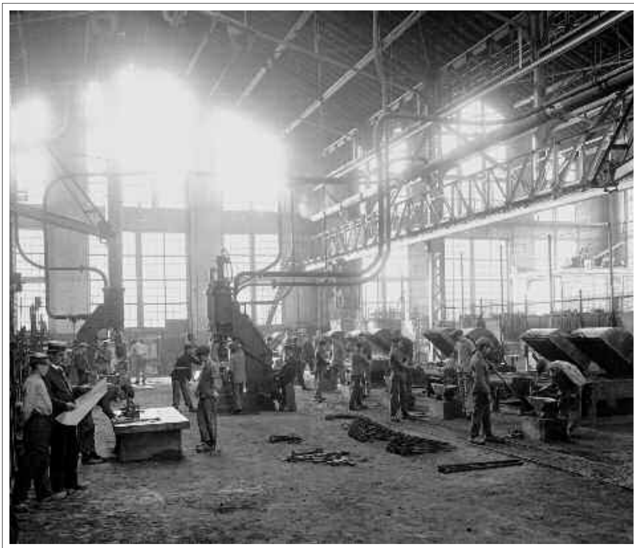
Usine du Creusot - Forges à mains - Nouvel atelier des élèves
