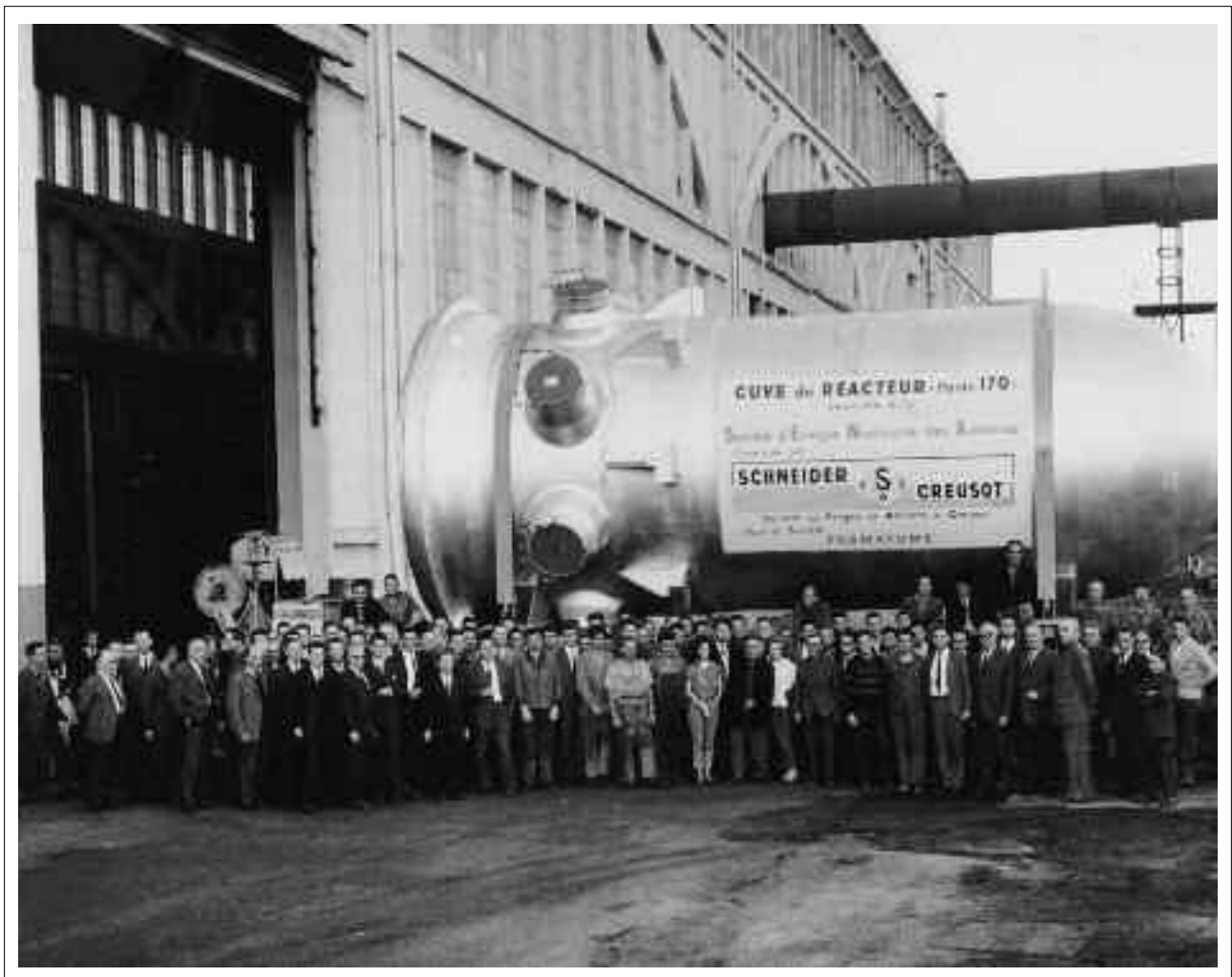
Sortie des ateliers Schneider-SFAC au Creusot d'une cuve de réacteur nucléaire de 170 t destinée à la centrale nucléaire dans les Ardennes de Seno à Chooz en septembre 1966
